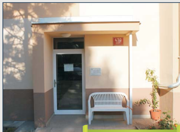
Tupolevova 470 po rekonstrukci
