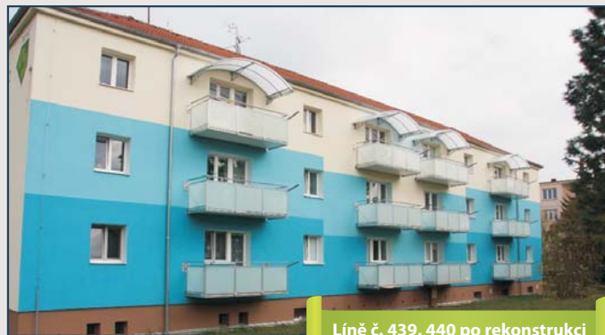
Líně č. 439, 440 po rekonstrukci
